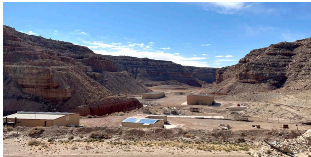
Bedeutende Infrastruktur in der ehemals produzierenden Tony M Mine, Utah (Quelle: Consolidated Uranium)
