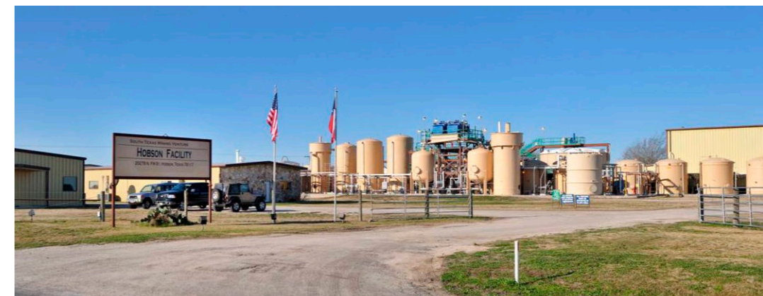
Die Produktionsanlage Hobson in Südtexas wurde vollständig renoviert und ist auf dem neuesten Stand der Technik. (Quelle: Uranium Energy)
